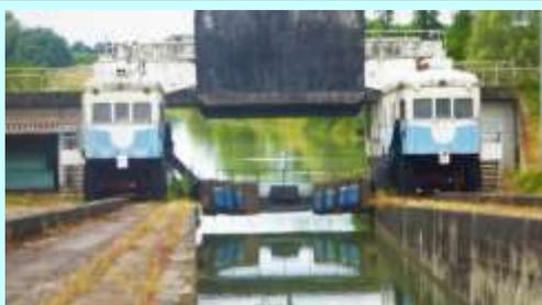
Au bas de la pente, les motrices et, entre elles, le masque qui, une fois descendu et le bateau en place, permet de monter le bateau sur l'eau retenue par le maque.
