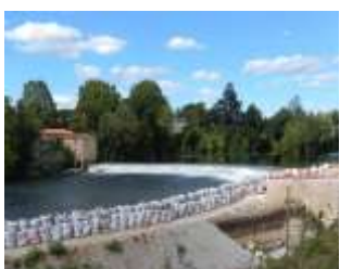
De g à d : moulin, seuil, écluse
