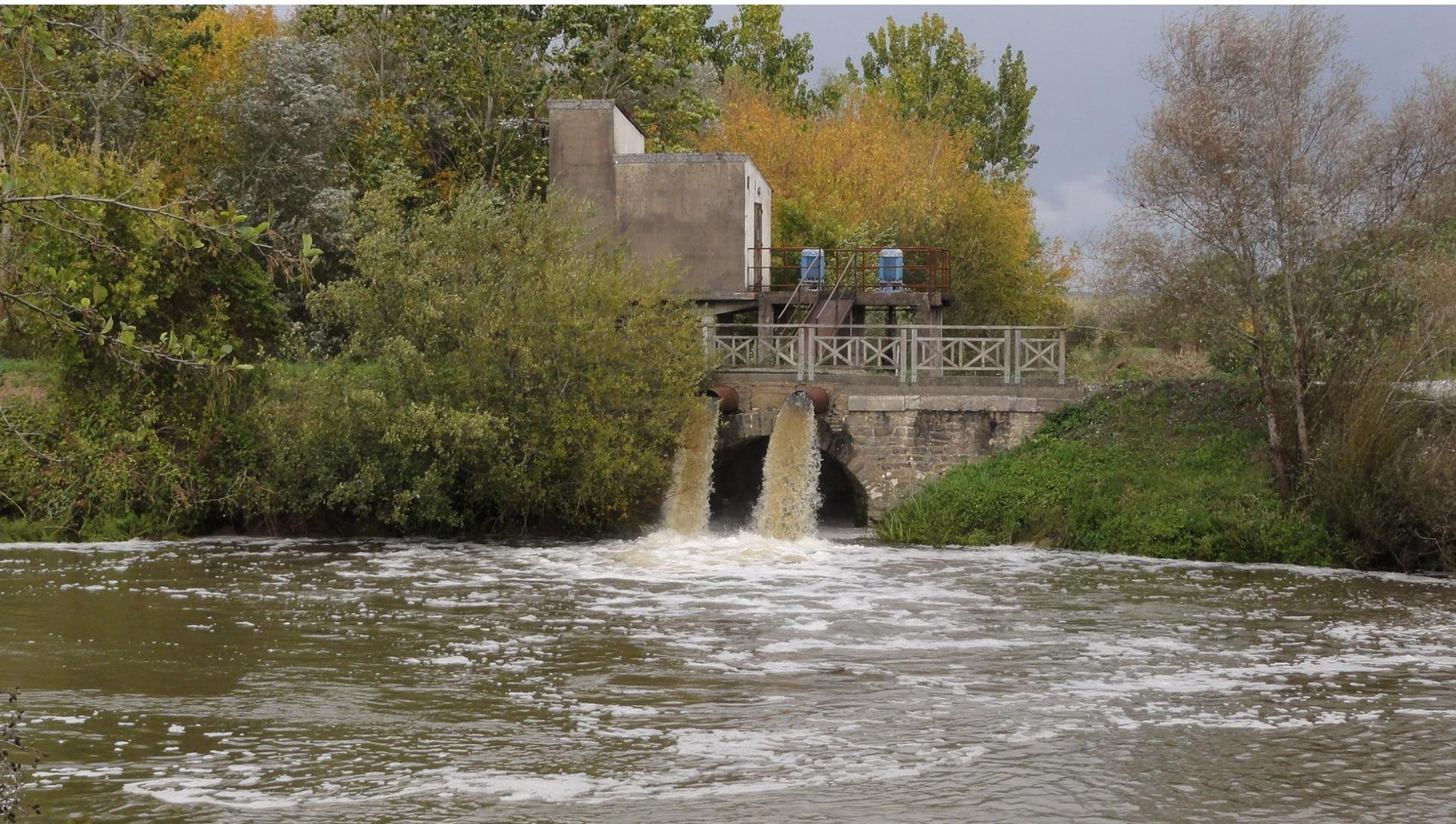
**..., des pompes remettent l'eau dans la rivière. Sur l'Adour, un système plus ancien – les barthes – fait repartir l'eau par de simples portes. A l'époque de leur construction, il n'y avait pas d'électricité mais la planète se portait mieux.**
