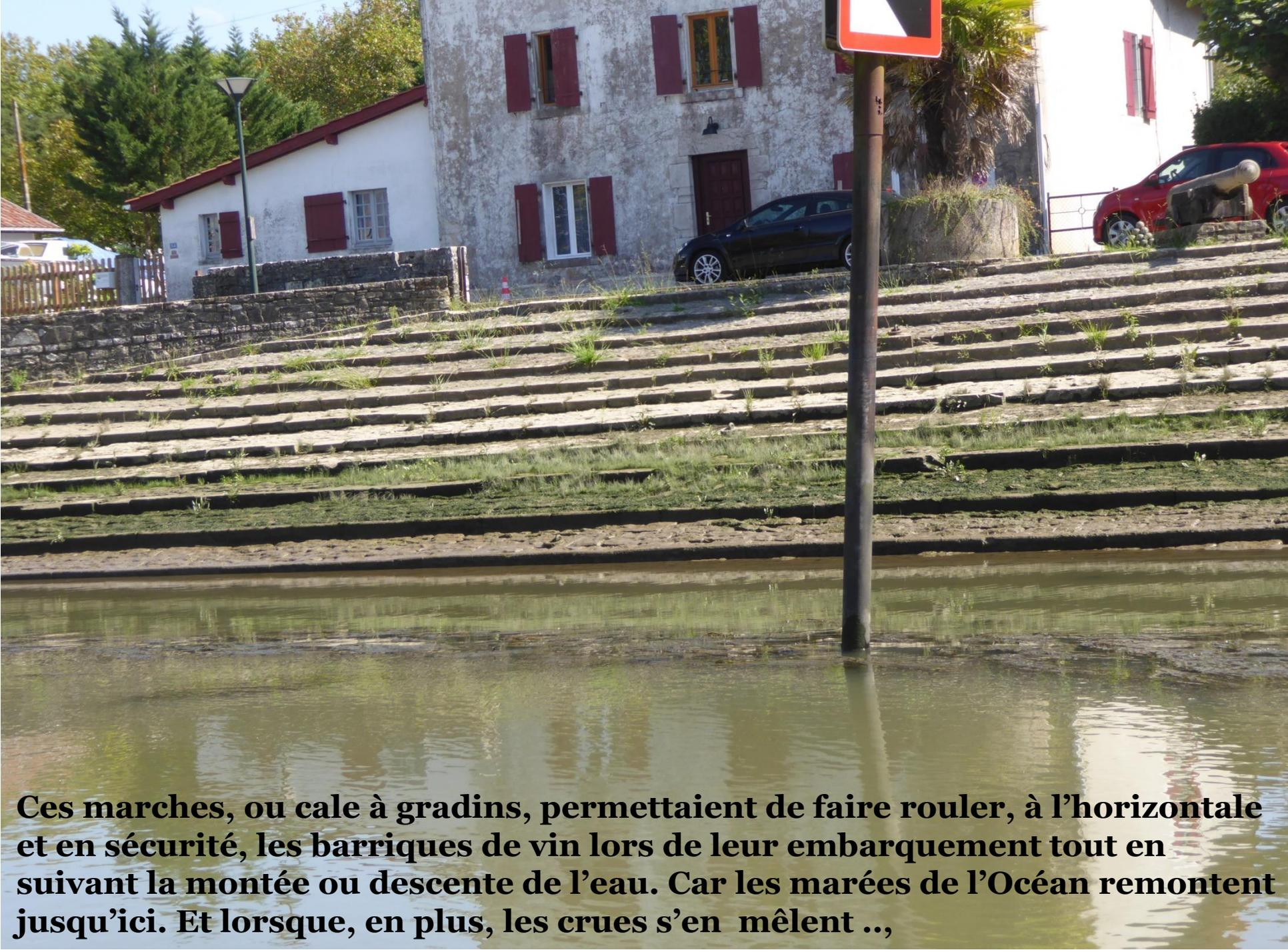
**Ces marches, ou cale à gradins, permettaient de faire rouler, à l'horizontale et en sécurité, les barriques de vin lors de leur embarquement tout en suivant la montée ou descente de l'eau. Car les marées de l'Océan remontent jusqu'ici. Et lorsque, en plus, les crues s'en mêlent ..,**
